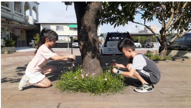
實地操作安裝太陽能燈具
