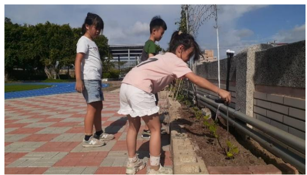
實地操作安裝太陽能燈具
