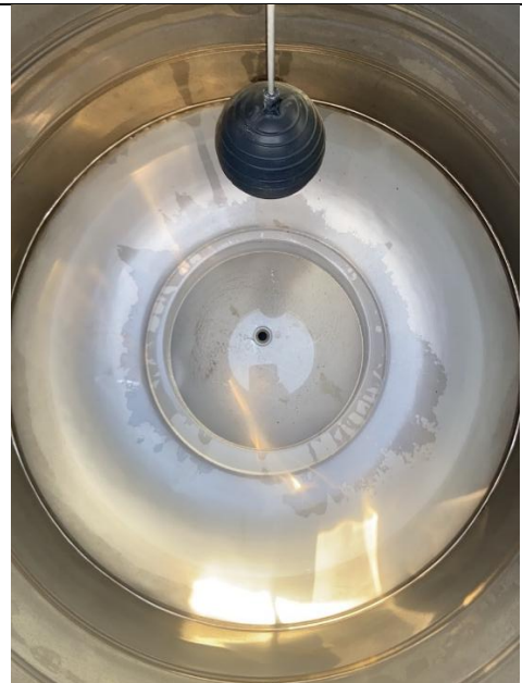
廚房上方水塔(3)清洗後
