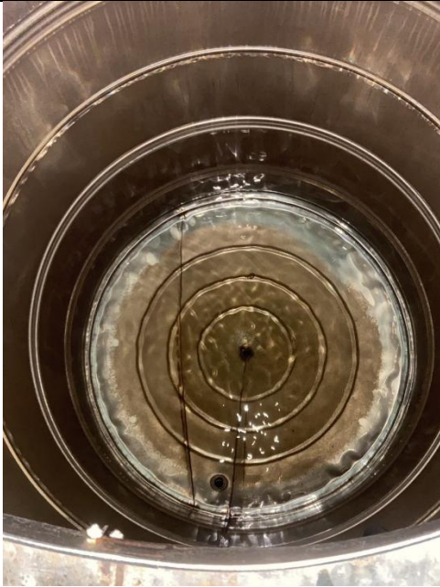
教學大樓頂樓水塔(4)清洗前
