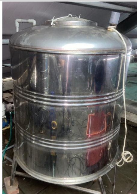
教學大樓頂樓水塔(1)外觀清洗後
