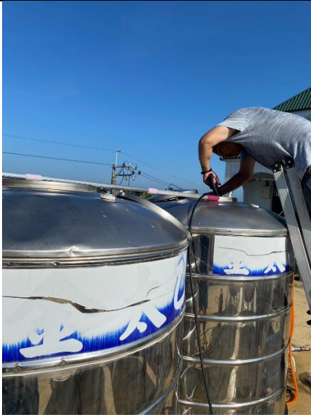
廚房上方水塔高壓水槍清洗
