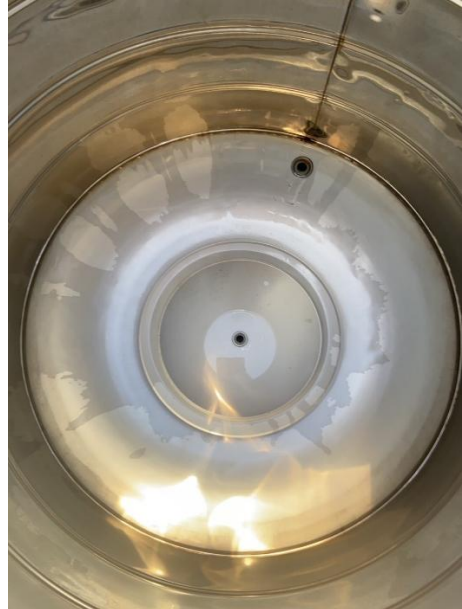
廚房上方水塔(2)清洗後
