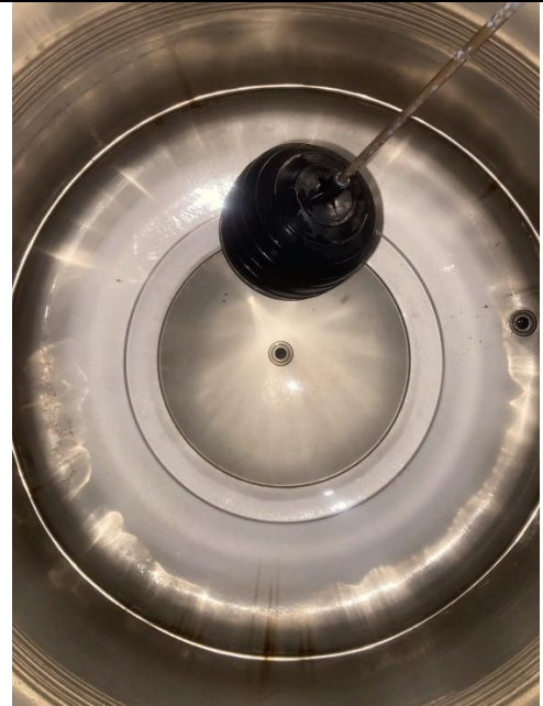
教學大樓頂樓水塔(1)清洗後
