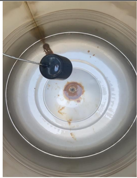
廚房上方水塔(1)清洗後
