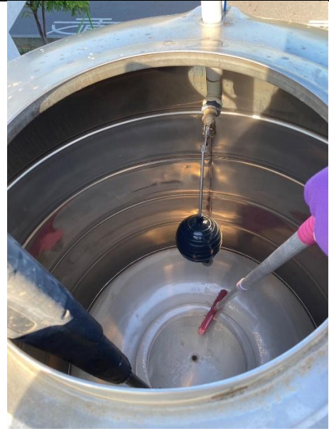
廚房上方水塔內部清洗
