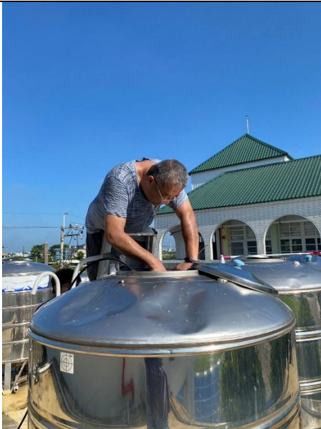
廚房上方水塔清洗
