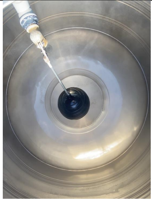
廚房上方水塔(4)清洗後
