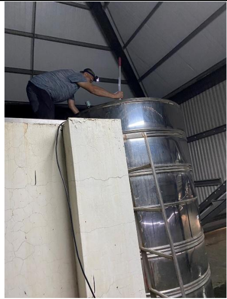
教學大樓頂樓水塔內部清洗
