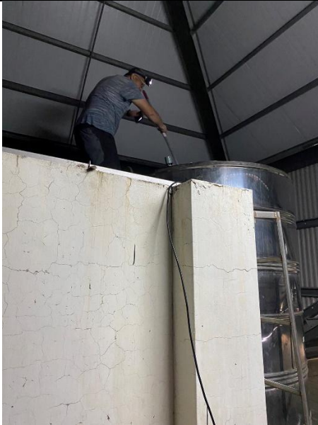
教學大樓頂樓水塔高壓水槍清洗
