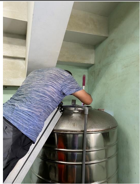
教學大樓頂樓水塔清洗
