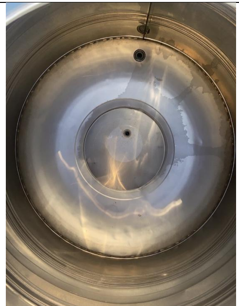
廚房上方水塔(6)清洗後
