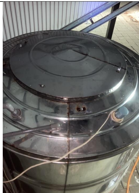
教學大樓頂樓水塔(4)外觀清洗後
