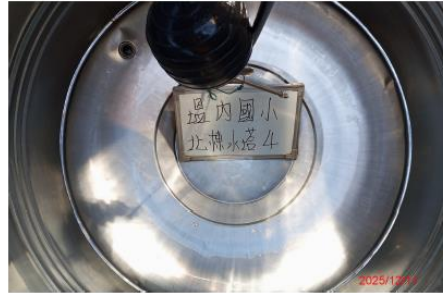
北棟水塔4 清洗後
