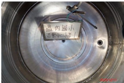
活動中心水塔1 清洗後
