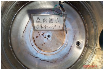
活動中心水塔1 清洗前
