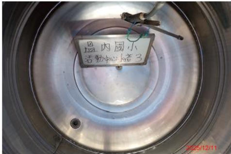
活動中心水塔3清洗後
