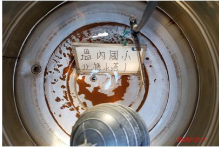
北棟水塔 1 清洗前
