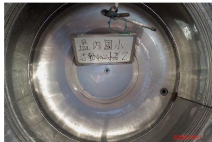
活動中心水塔清洗後
