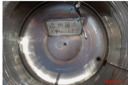
活動中心水塔2 清洗前
