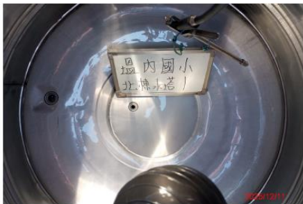
北棟水塔 1 清洗後
