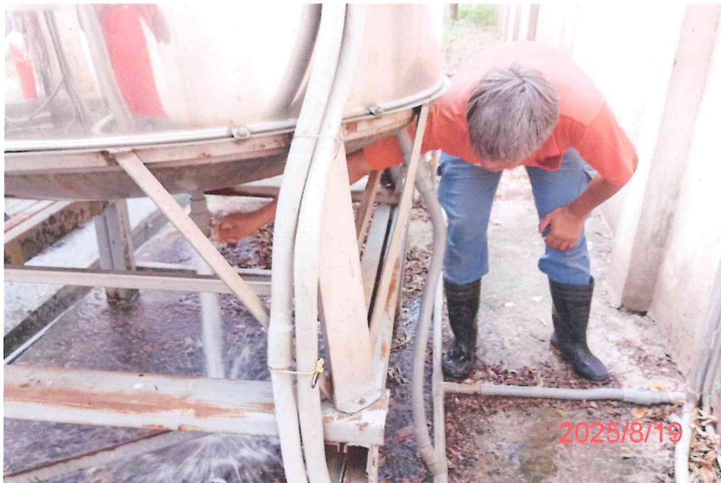
管路檢查作業中
