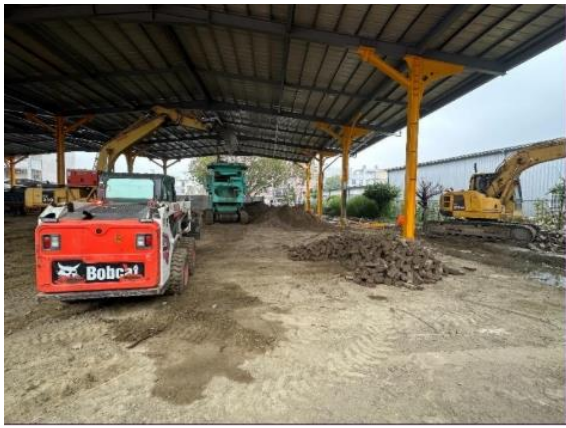
說明：校園光電球場施作, 級配層的部分利用學校舊磚現場請破碎機現場破碎用於球場底層, 達到永續回收再利用。
