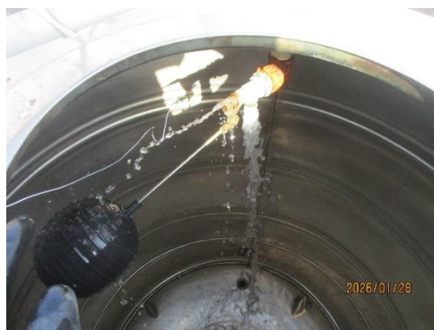
說明：水塔清洗 2
