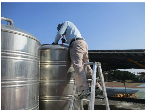
說明：水塔清洗 1
