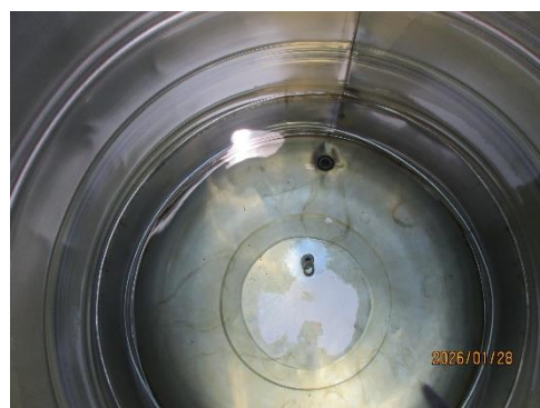
說明：水塔清洗 4
