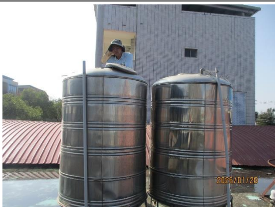
說明：水塔清洗 5
