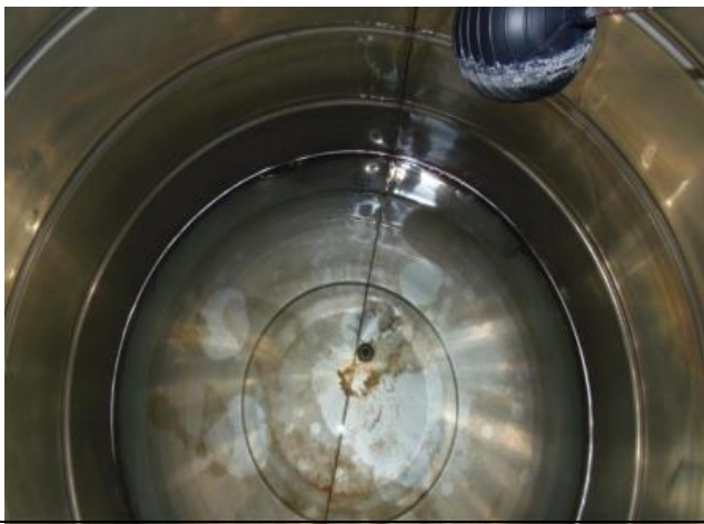
說明：水塔清洗前
