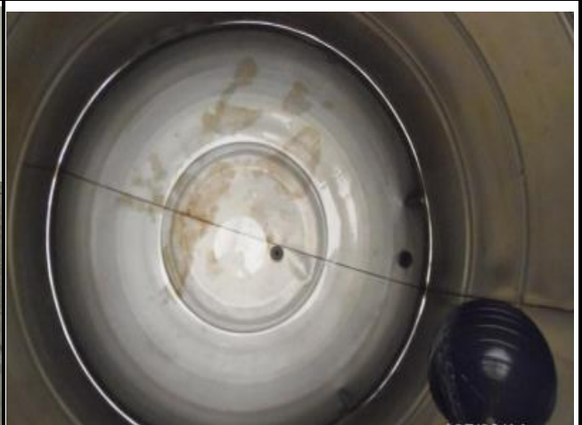
說明：水塔清洗後
