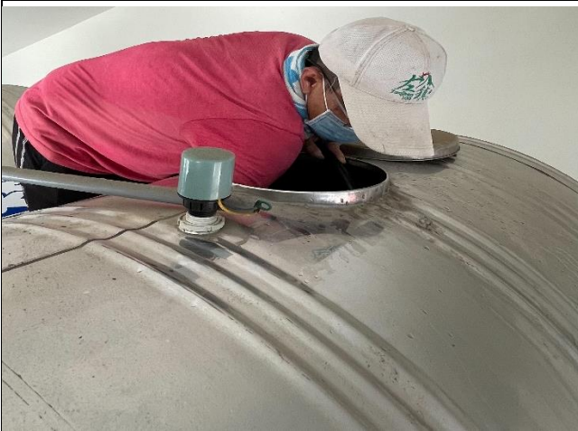
說明：水塔清洗中
