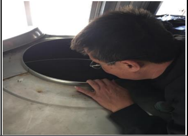
說明：水塔清洗中
