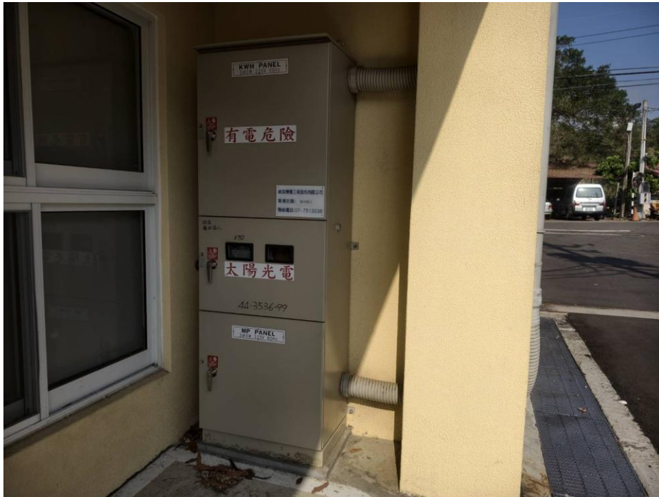
說明：節能設施-進行太陽光電設置
