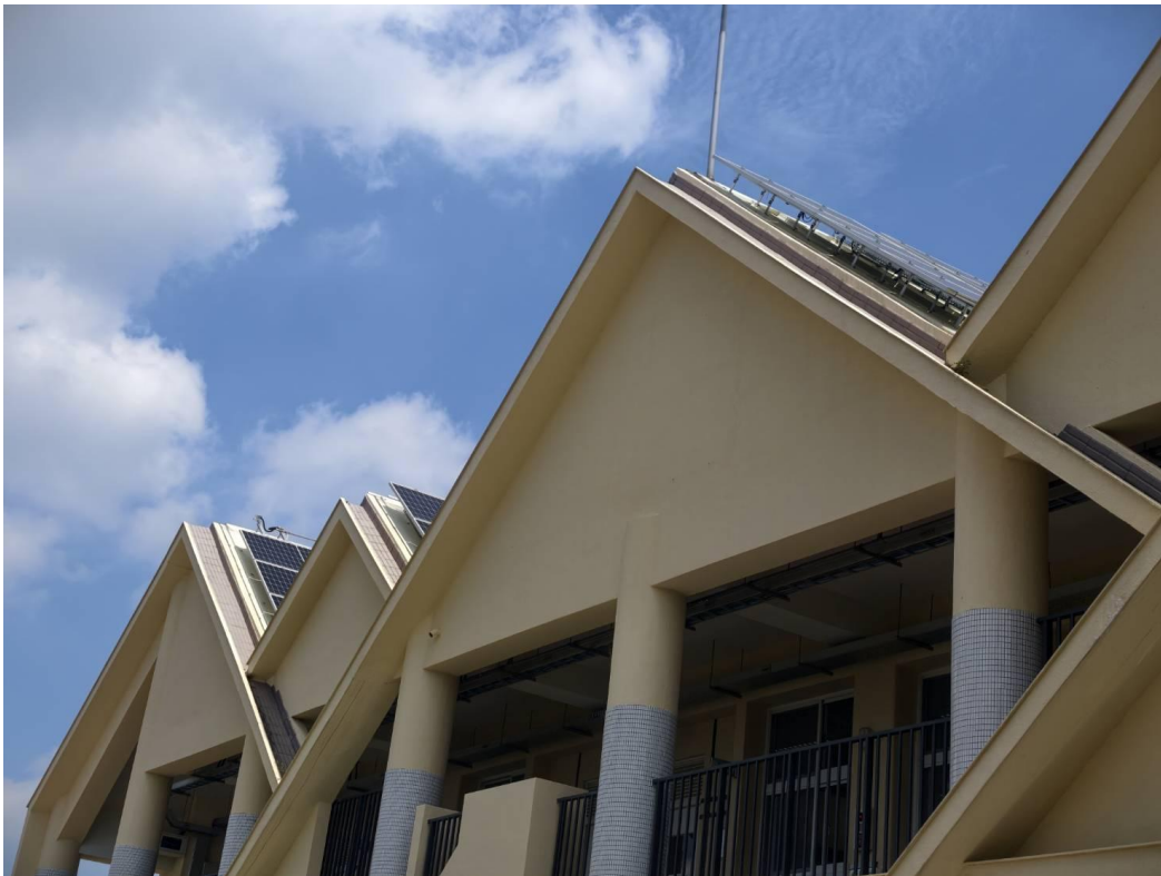
說明：設置屋頂型太陽光電
