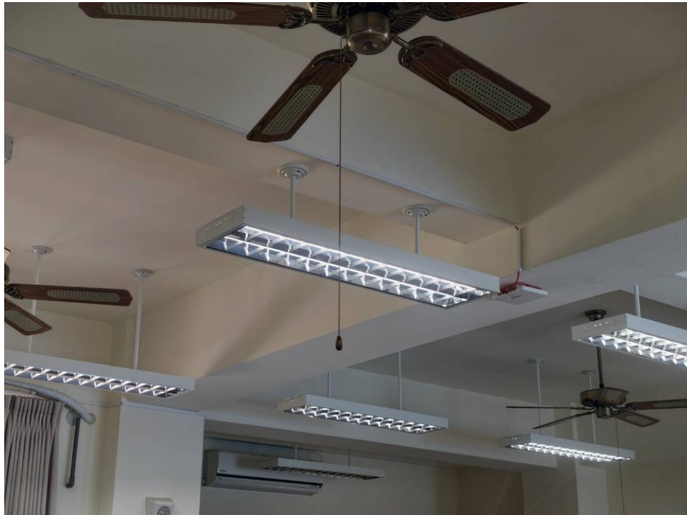
說明：節能設施-全面使用 LED 節能燈具
