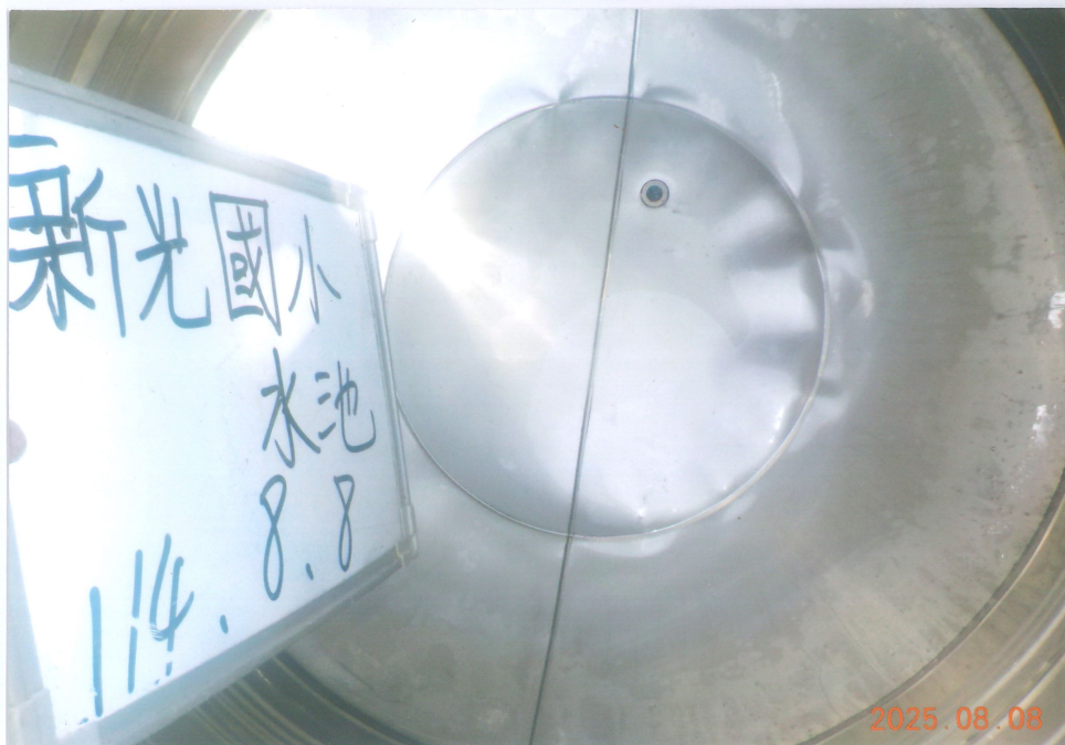
蓄水池清洗後
