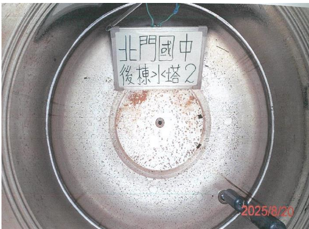
說明：水塔清洗前
