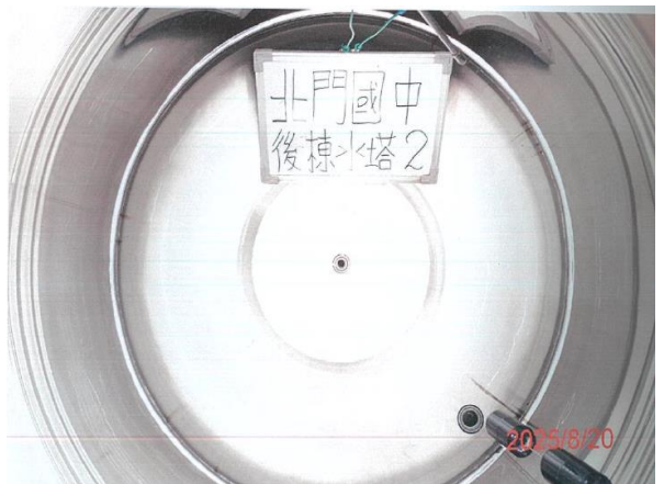
說明：水塔清洗後
