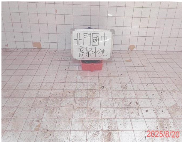
說明：高架水塔清洗前
