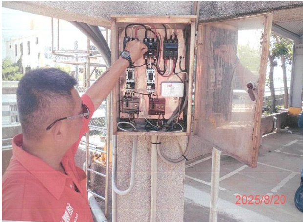
說明：水塔清洗電控檢查作業
