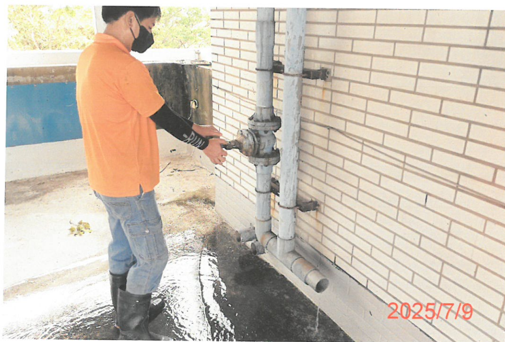
管路檢查作業中
