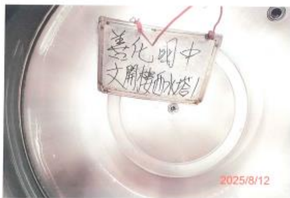
(文開樓西-1)水塔清洗後
