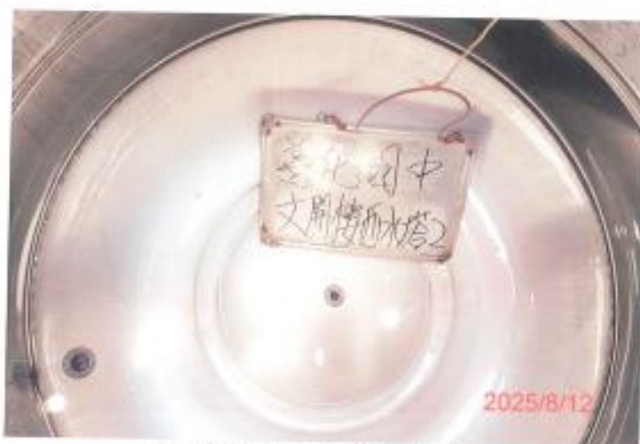
(文開樓西-2)水塔清洗後
