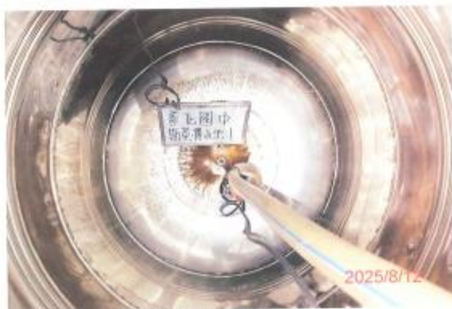
(斯菴樓-1)水池清洗前
