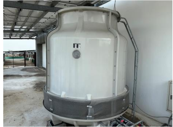
說明：冷卻水塔加裝隔網預防病媒蚊(2)
