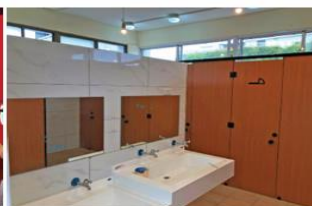
◆禮堂廁所整修後
