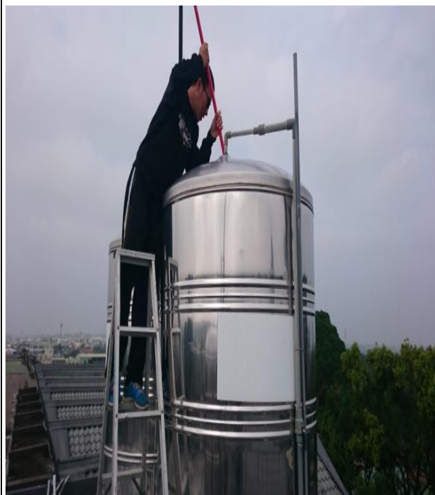
內容說明：水塔定期清洗
