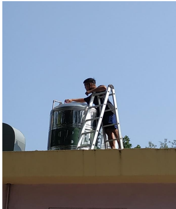
內容說明：水塔定期清洗
