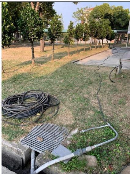
利用馬達抽出水溝內用水
