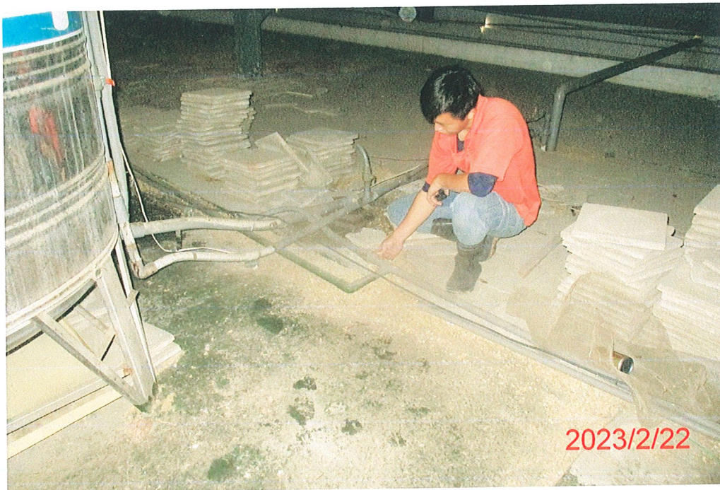
管路檢查作業中
