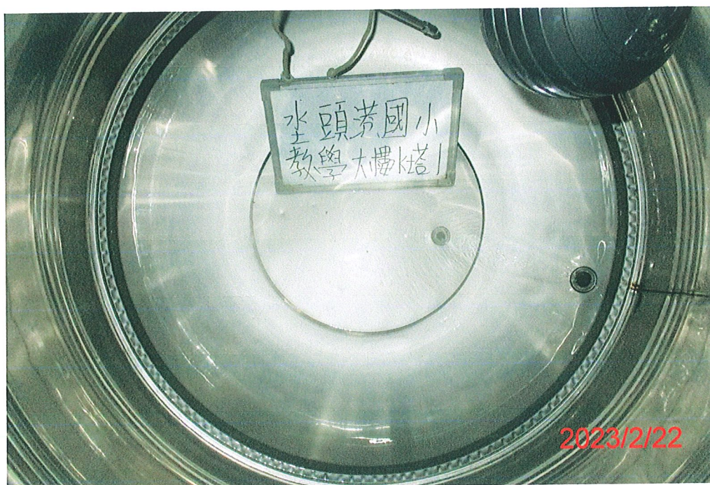
(教學大樓-1)水塔清洗後
