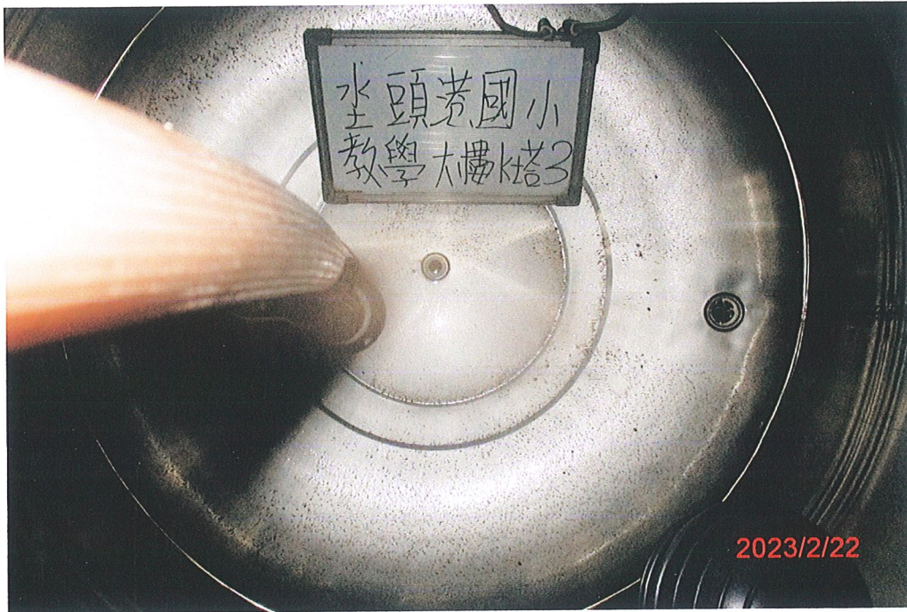
(教學大樓-3)水塔清洗前
