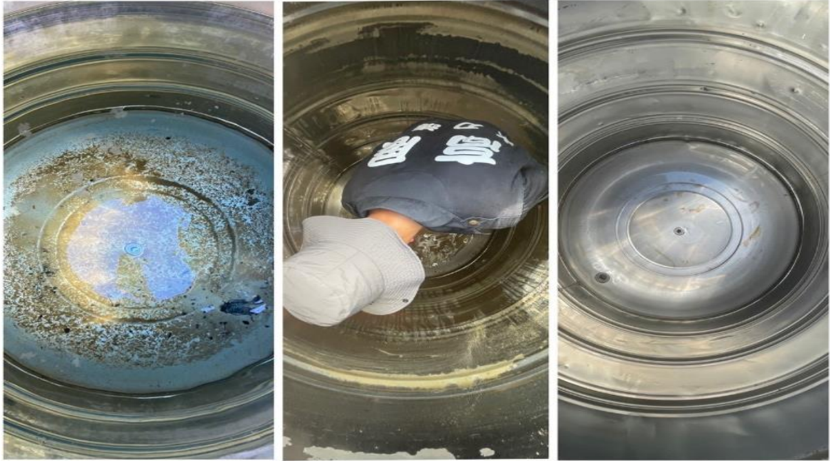
說明：廚房水塔清洗-清洗前. 中. 後
