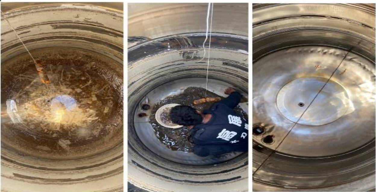
說明：育賢樓水塔清洗-清洗前. 中. 後
