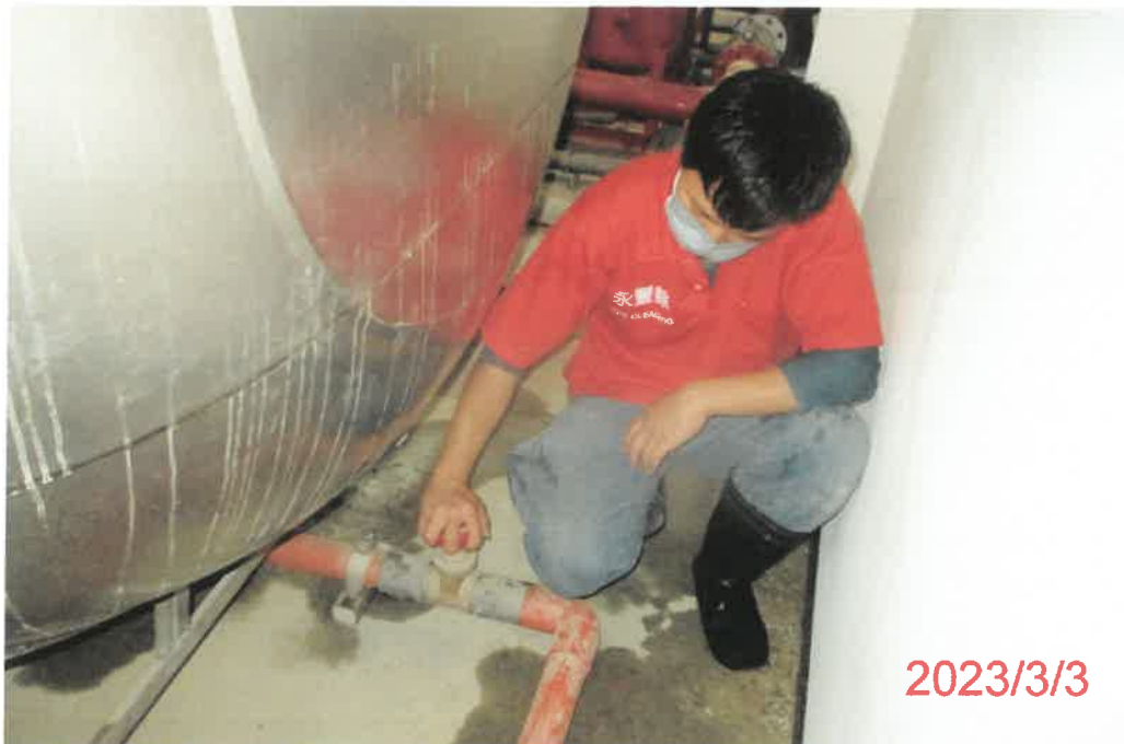
管路檢查作業中
