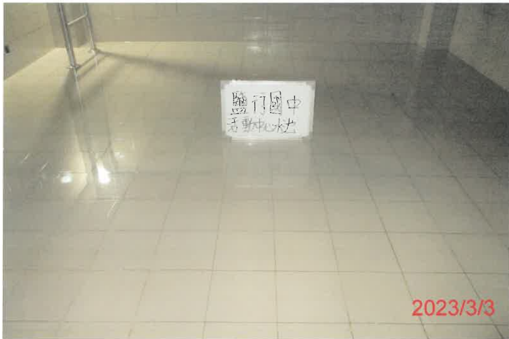
(活動中心)水池清洗後
