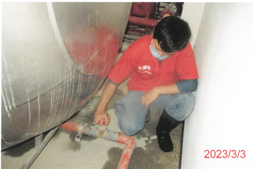
管路檢查作業中
