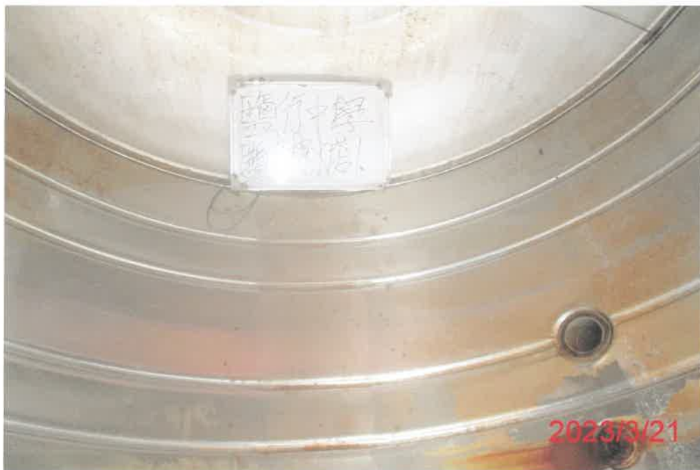
(鹽行樓-1)水塔清洗後
