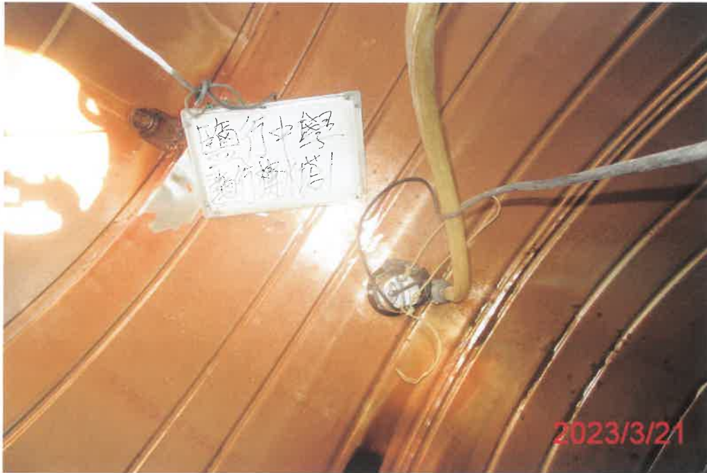
(鹽行樓-1)水塔清洗前
