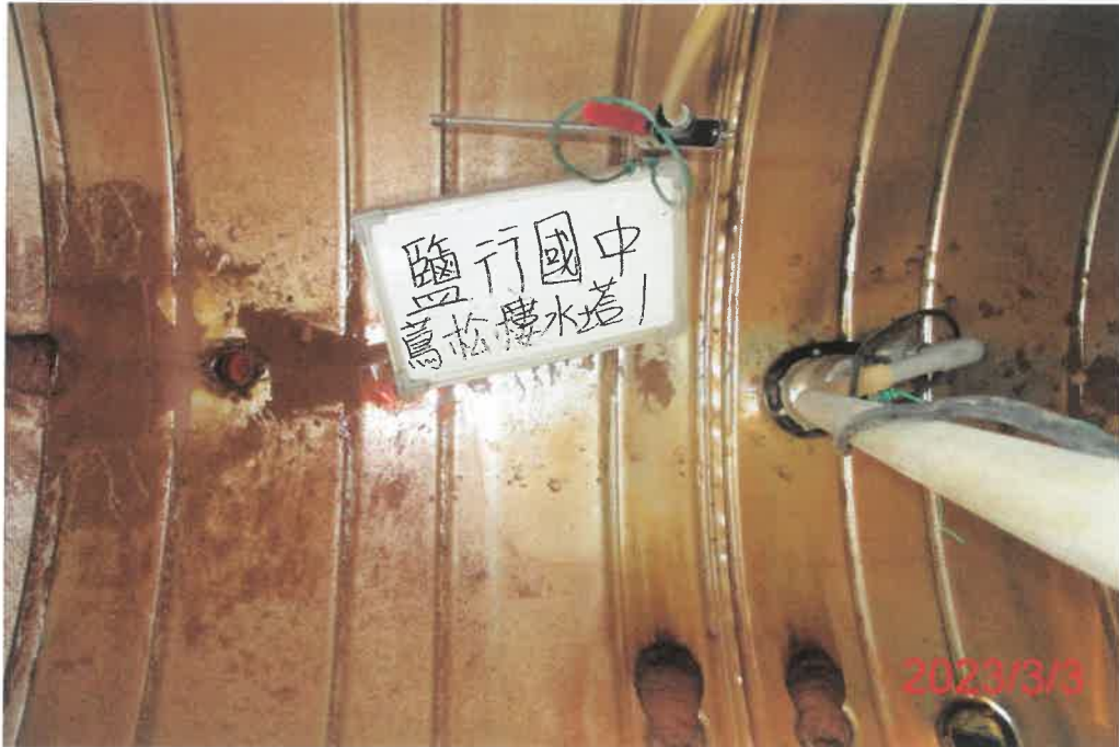
(蔦松樓-1)水塔清洗前
