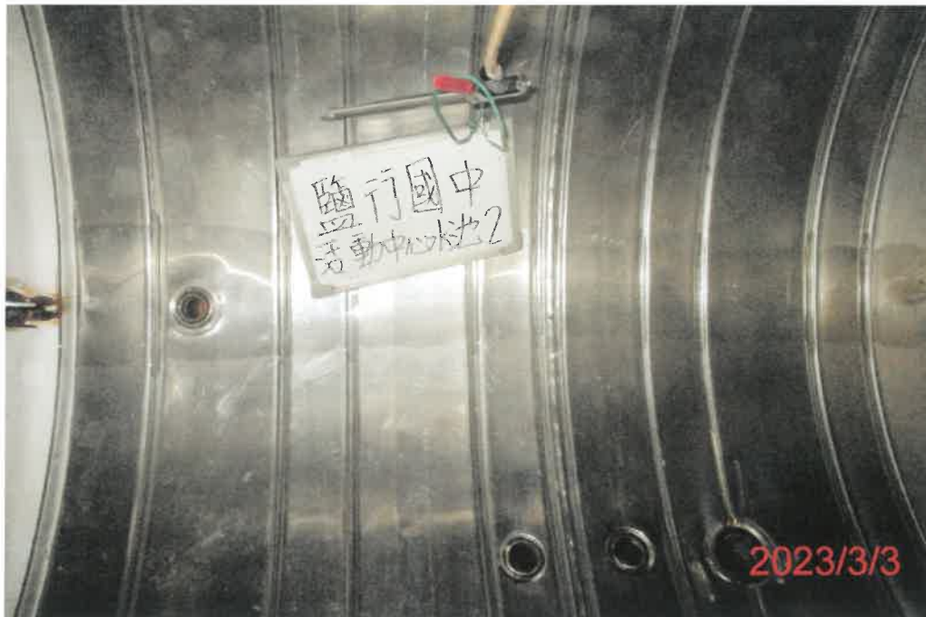
(活動中心-2)水池清洗後
