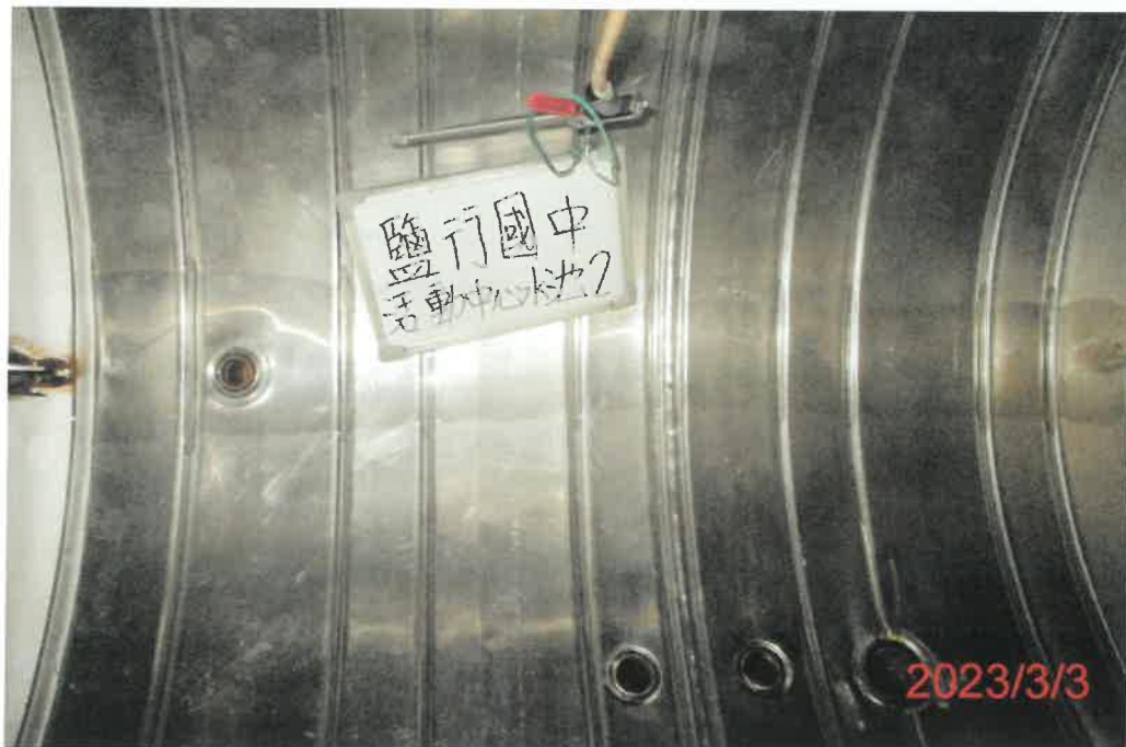
(活動中心-2)水池清洗後
